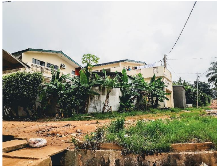
Photo 33 : Absence totale de caniveaux aux abords de la chaussée à Bingerville (Source : Notre enquête, 2018)
