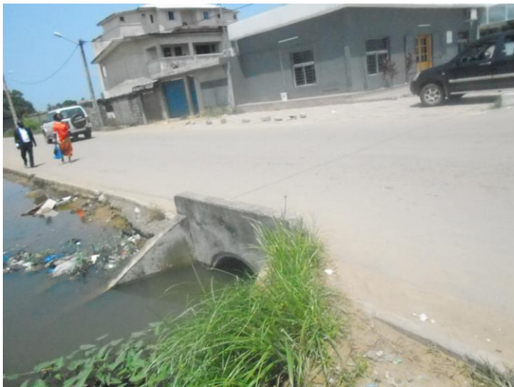
Photo 32 : Ouvrage d'assainissement obstrué aux abords de la voie à Grand-Bassam (Source : Notre enquête, 2018)
