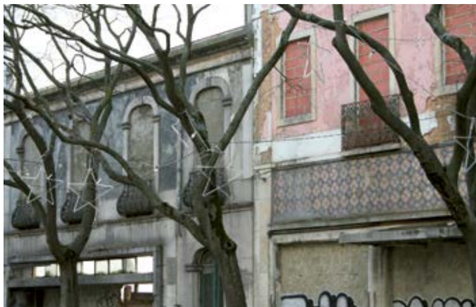
Fotografia 5. Prédios devolutos e em estado de ruína (DGT, 2013)
